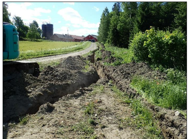
Hakoisten alue. Vasen: valvontatyöt loppuivat kartanon talousrakennusten n-puolelle, johon tulee muuntajakoppi. Kuvassa näkyvä matala kaivanto on kaivettu muuntajakopin asennukseen tarvittavaan määräsyyvyyteen. Pohjoiseen. Oikea: Hamppulantien eteläosan kaapelikaivantoa, kohdassa missä Hamppulantien länsilaitaa kulkeva kaapeliojaa haarautuu kohti linnavuoren pohjoislaitaa. Etelään.
